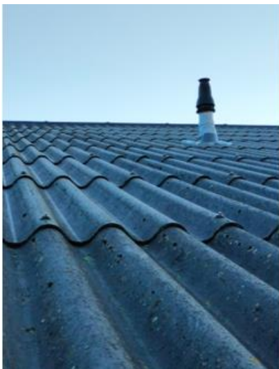
Het dakvlak is strak aan de gootzijde is vogelschroot aanwezig.
