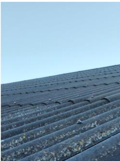
Het dakvlak is strak aan de gootzijde is vogelschroot aanwezig.
