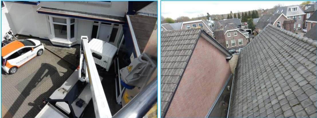
Foto's: Constructiecheck/ sporenonderzoek met een hoogwerker 14 april 2021.
