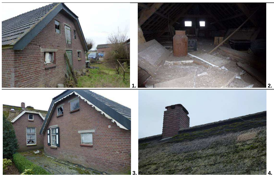
Indicatie plangebied Foto 1: te slopen schuur buitenzijde Foto 2: te slopen schuur binnenzijde (zolder) Foto 3: te slopen schuur en woning Foto 4: dak te slopen woning met gaas afgezet
