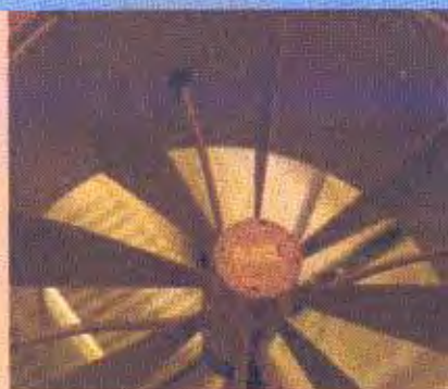
Kies voor zo groot mogelijke meetsmoor units. Als ze nog net terug te regelen zijn tot de minimum ventilatiebehoefte van een afdeling is het goed.
