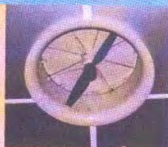
Bij werken met frequentieregelaars is het vaak interessant om te kiezen voor iets grotere ventilatoren dan strikt volgens de normen noodzakelijk is.
