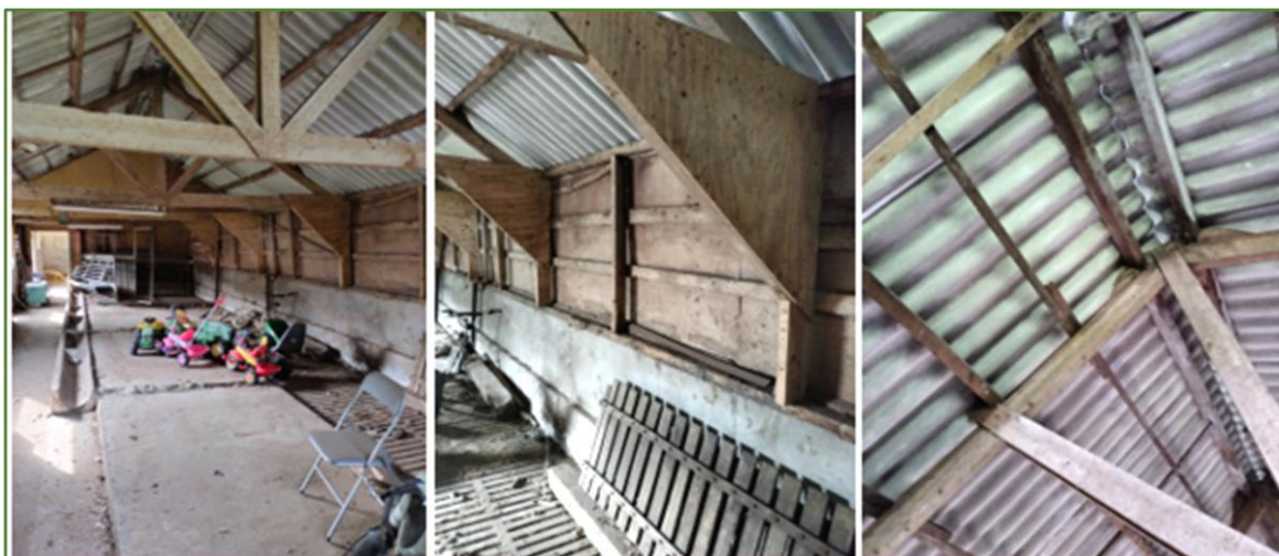
Geen spouwruimte en dakbeschot aanwezig, de ruimtes waren goed te beoordelen.
