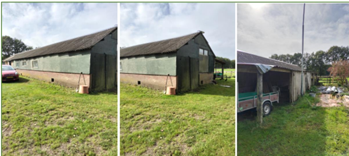
De te slopen schuur noord- zuidzijde en omliggend gebied.
