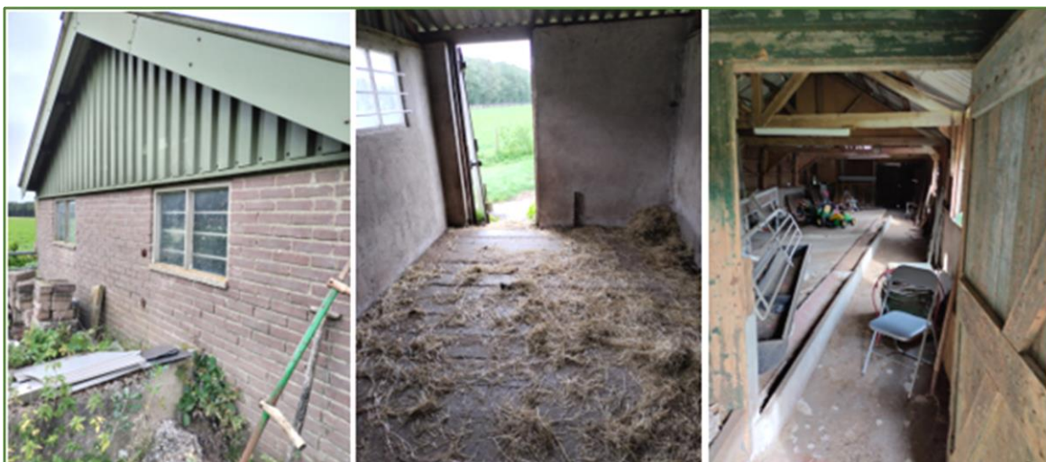
Gevel westzijde geen spouwruimte, gedeelte ingericht als dierenverblijf, overige deel wordt gebruikt als opslagruimte.
