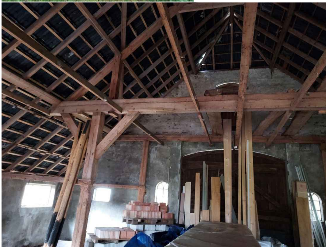
Figuur 2 Gebouw A (voormalige stal)
