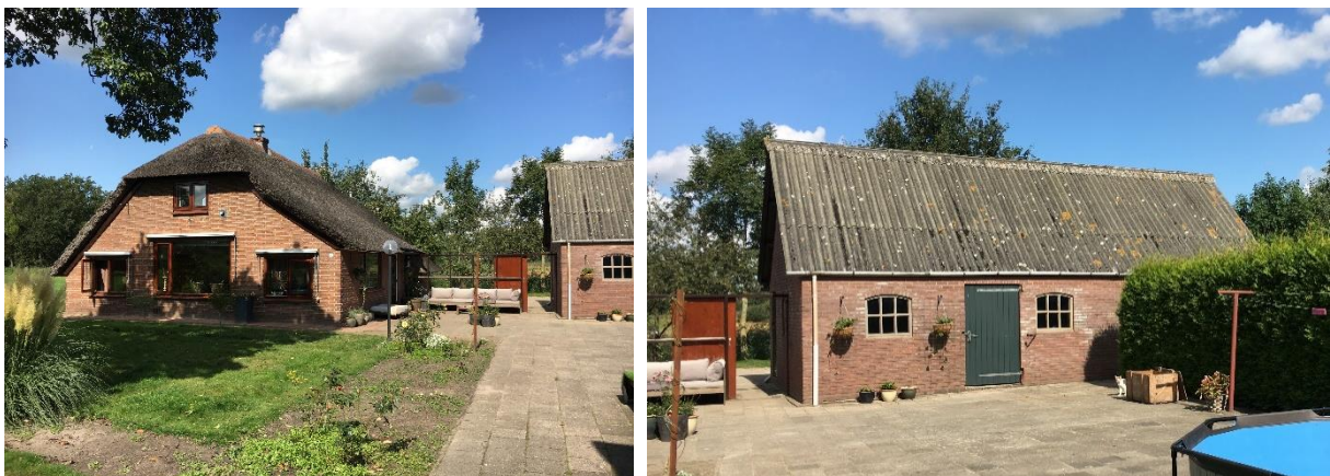
Figuur 2. Impressie van de woonboerderij aan Koperweg 5 met zicht op een van de drie schuren met steense muur en golfplaten dak. Opname 9 september 2019
