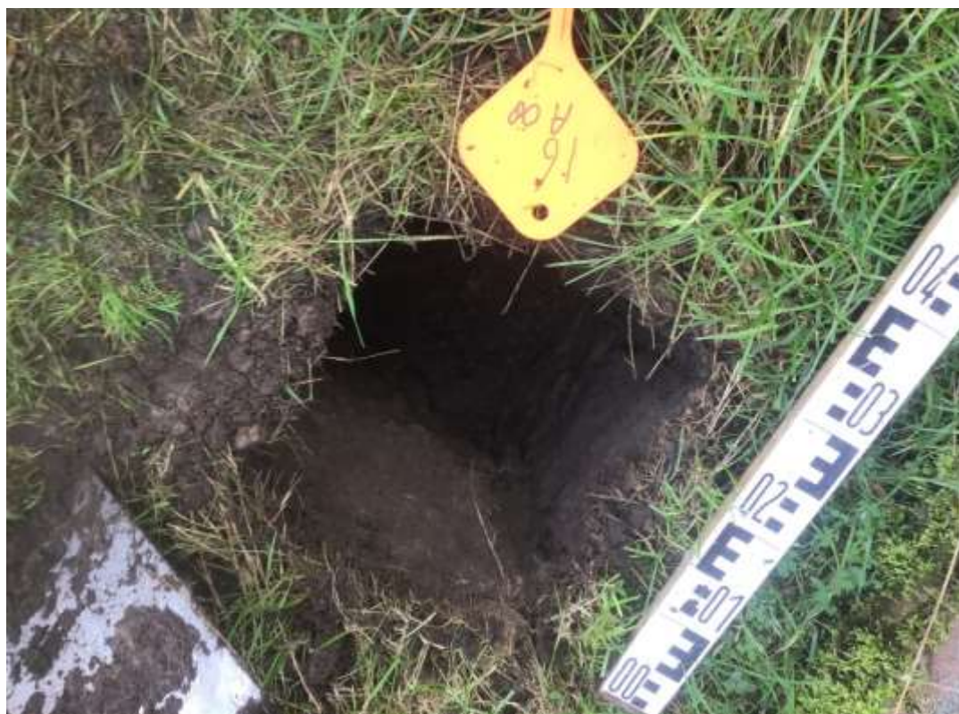
Foto 26: inspectiegat A08 0,2-0,5 m-mv
