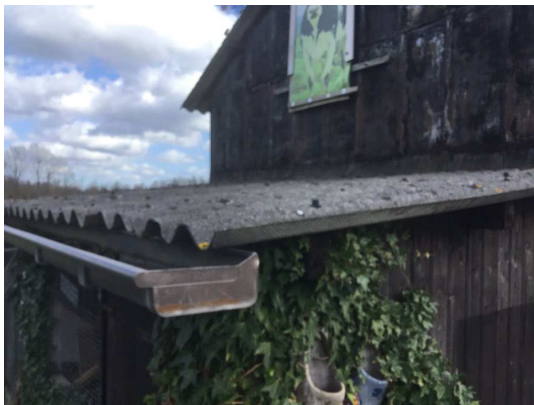
AC golfplaat (dak)
