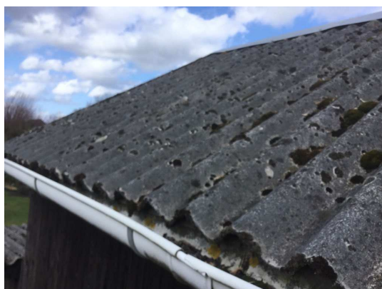
AC golfplaat (dak)
