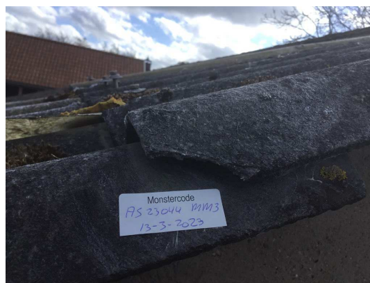
AC golfplaat (dak)
