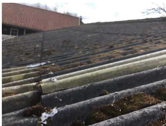
AC golfplaat (dak)
