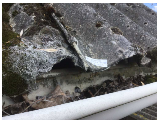
AC golfplaat (dak)
