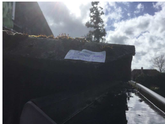
AC golfplaat (dak)
