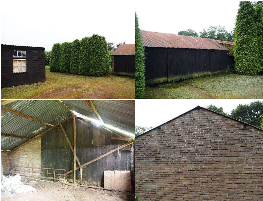
Figuur 3. De zuidelijke schuur (oost) bestaat uit één open ruimte met enkellaags stalen golfplatendak met enkele gaten en spleten en wordt gebruikt als stalling voor de auto. De ruimte is verder leeg.
