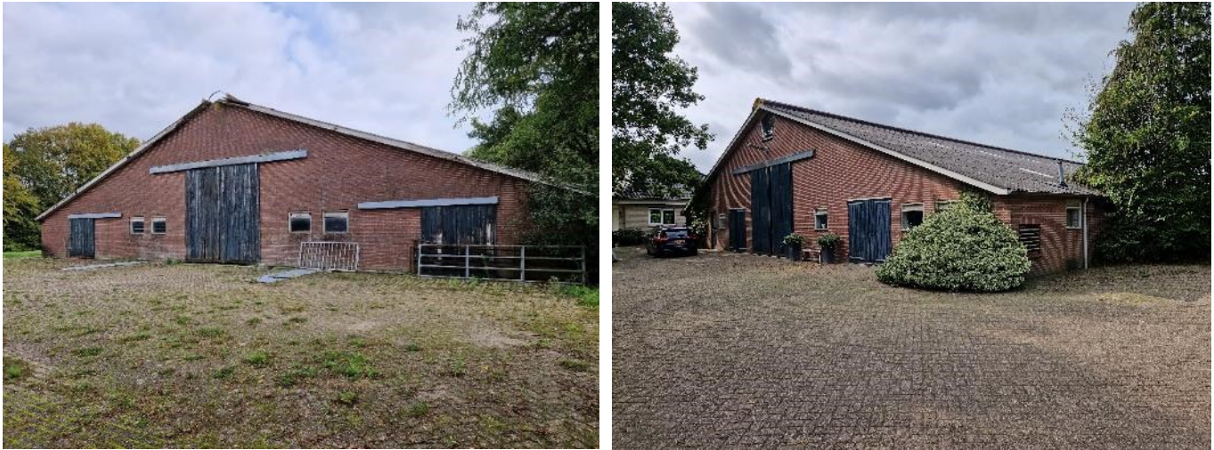
Figuur 17 Foto-impressie projectgebied. Foto rechts: Westgevel schuur. Foto links: Oostgevel schuur
