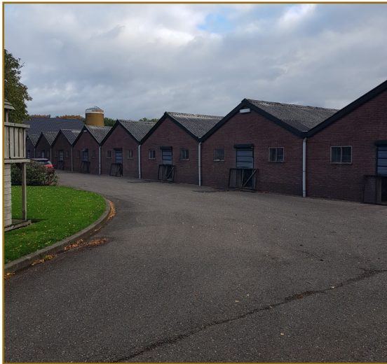
Afb. 2.1: Overzichtsfoto van de te slopen stal.
