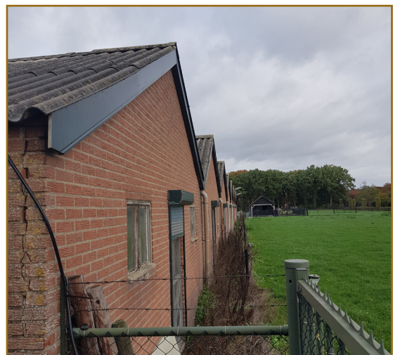
Afb. 2.6: De achterkant (oostkant) van de stal. Hier is goed te zien dat er geen ruimte is voor vleermuizen om onder de boelplanken te kruipen.
