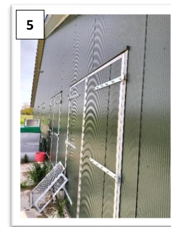
Foto3-4-5, achterzijde bestaat uit geïsoleerde damwand beplating en is volledig afgesloten.
