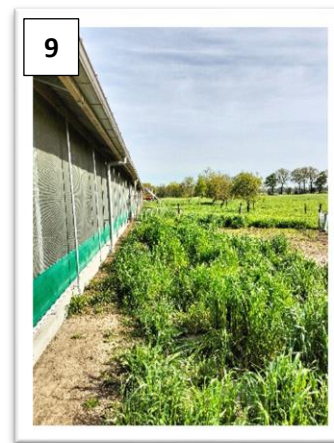
Foto3-4-5, achterzijde bestaat uit geïsoleerde damwand beplating en is volledig afgesloten.
