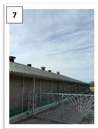
Foto3-4-5, achterzijde bestaat uit geïsoleerde damwand beplating en is volledig afgesloten.
