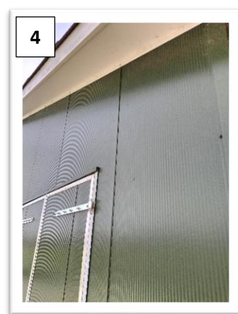
Foto3-4-5, achterzijde bestaat uit geïsoleerde damwand beplating en is volledig afgesloten.
