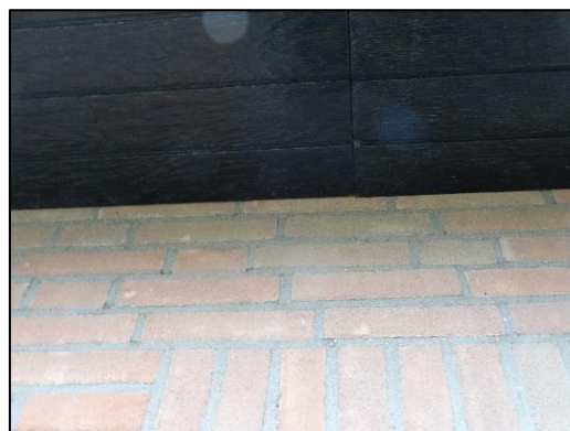
Fig. 2.12 Dakoverstek gebouw nr. 1 (bron: FF Solutions)
