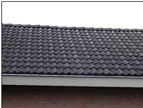
Fig. 2.5 Dak van gebouw nr. 1 (bron: FF Solutions)
