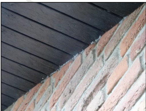
Fig. 2.13 Dakoverstek gebouw nr. 2 (bron: FF Solutions)
