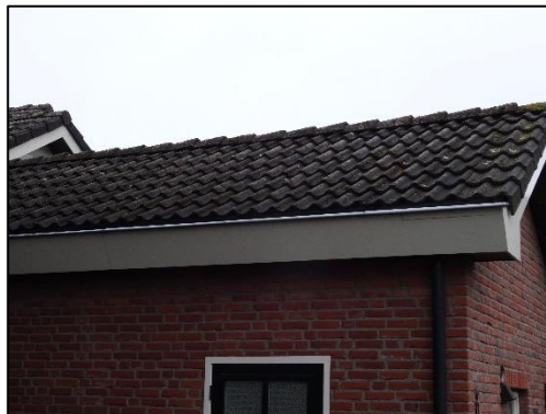
Fig. 2.6 Dak van gebouw nr. 2 (bron: FF Solutions)
