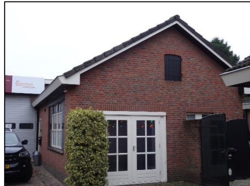
Fig. 2.3 Voorzijde gebouw nr. 1 (bron: FF Solutions)
