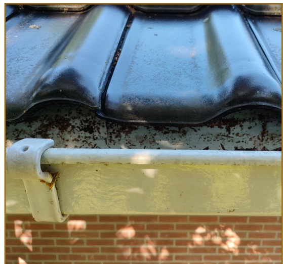
Afbeelding. 4.10: Dakpannen van toiletgebouw E zijn van een plat type.
