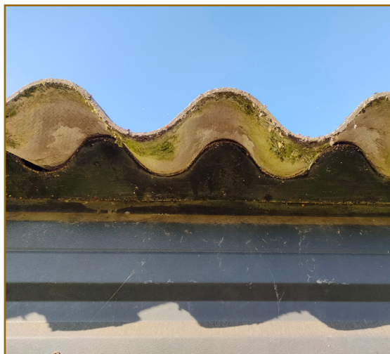
Afbeelding. 4.11: Ruimte onder golfplaten dak van schuur D is afgesloten.
