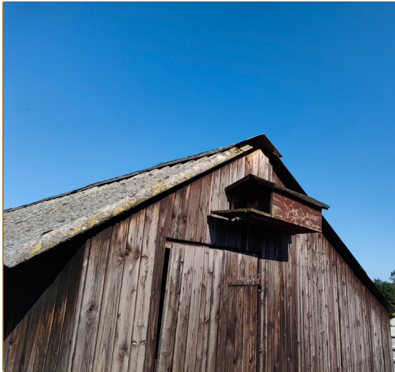
Afbeelding. 4.7: Nestkast voor steenuil aan oostelijke gevel schuur F.
