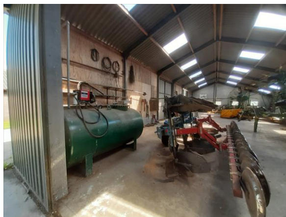
Foto 4: Meest westelijke schuur met bovengrondse dieseltank.
