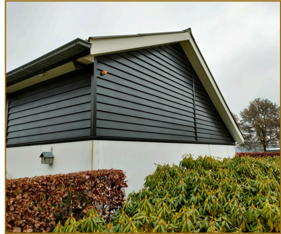
Afb. 2.2: De kopse kant van de schuur gezien vanaf het zuidwesten. Men is voornemens dit deel te verwijderen. Er is een nest van een algemene broedvogel aangetroffen in de rechter dakrand.
