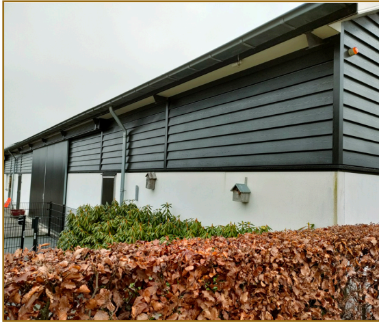
Afb. 2.1: Schuur gezien vanaf het zuidwesten. Men is voornemens om het deel tot aan de schuifdeur te verwijderen om plaats te maken voor een woning.
