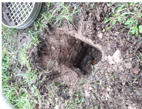
Foto 4: Inspectiegat (7) met sterke puinbijmenging
