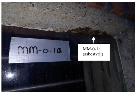
Foto 3: Asbestvrije beglazingskit in/aan raamkozijnen van schuur 1.
