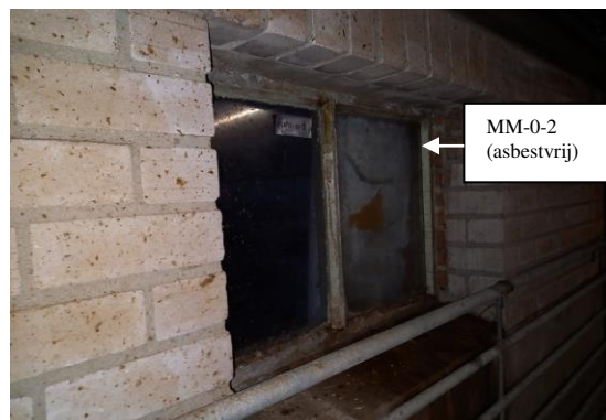
Foto 6: Asbestvrije stopverf in/aan raamkozijnen van schuur 1.
