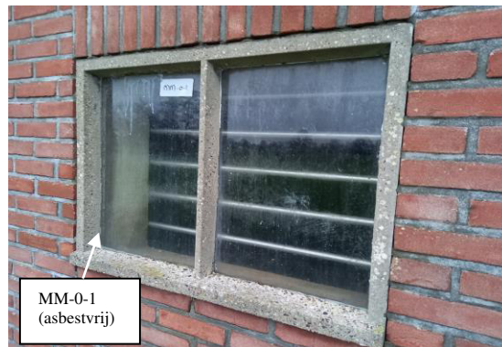
Foto 2: Asbestvrije beglazingskit in/aan raamkozijnen van schuur 1.
