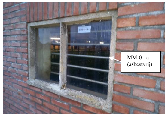
Foto 4: Asbestvrije beglazingskit in/aan raamkozijnen van schuur 1.
