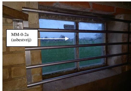
Foto 8: Asbestvrije stopverf in/aan raamkozijnen van schuur 1.
