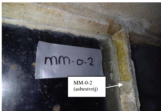
Foto 5: Asbestvrije stopverf in/aan raamkozijnen van schuur 1.
