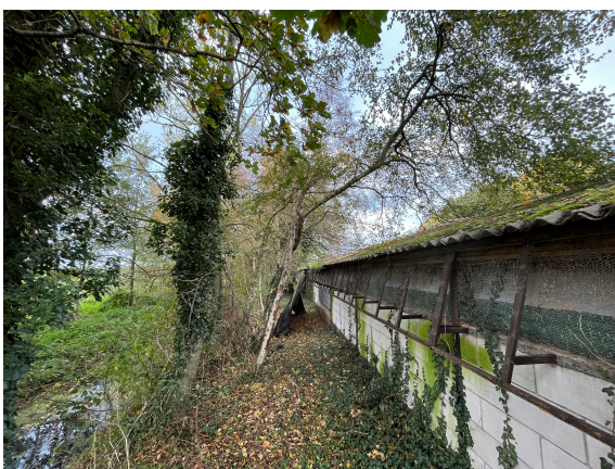
Figuur 4: bomen langs bestaande sloot
