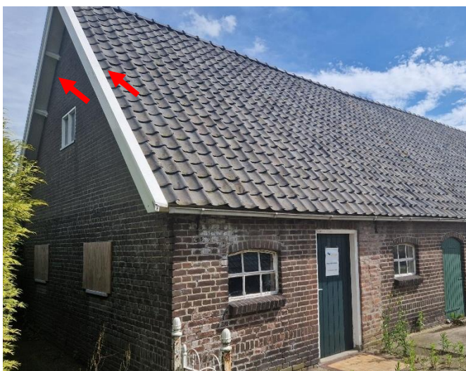
Figuur 31 De schuur van Nijkerkerweg 128 is onder andere toegankelijk ter hoogte van de dakrand (zie rode pijlen) waardoor vleermuizen mogelijk in de constructie verblijven
