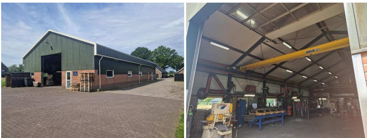
Figuur 43 Foto-impressie plangebied. Figuur links: Achterzijde van de te amoveren loods op het erf van Nijkerkerweg 126-1. Figuur rechts: Binnenzijde van de loods, in gebruik door een staalbedrijf
