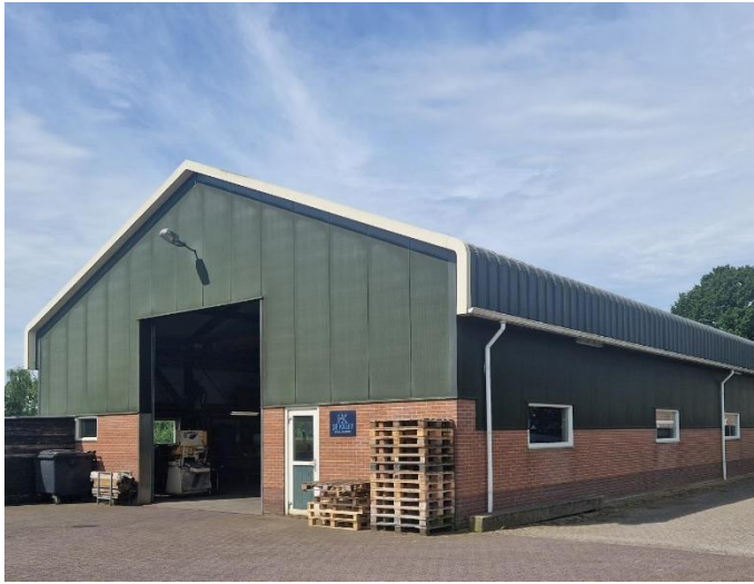
Figuur 14 De loods van Nijkerkerweg 126-1 heeft een metalen gevel waardoor huismus, steenuil en kerkuil hier geen openingen vinden voor nest- en rustplaatsen in de constructie
