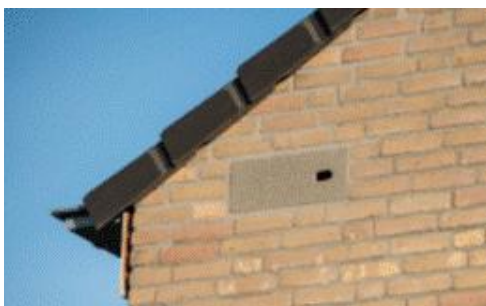
Figuur 6. Voorbeeld van inbouwvoorziening prefab kast model GZP2 van de firma Unitura (links) en praktijkvoorbeeld van Arcadis (rechts).
