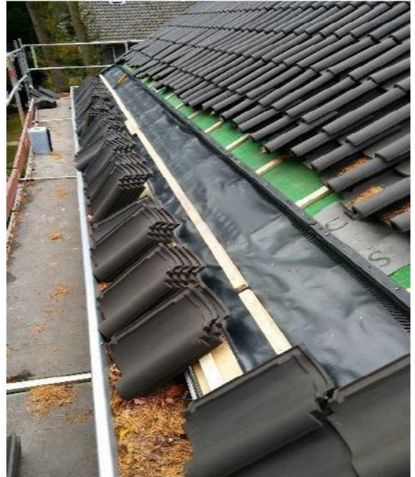
Figuur 5. Ophogen van vogelschroot naar derde pannenlat om ruimte onder de eerste rijen dakpannen toegankelijk te houden met links voorbeeld van Unitura en rechts praktijkvoorbeeld Arcadis.
