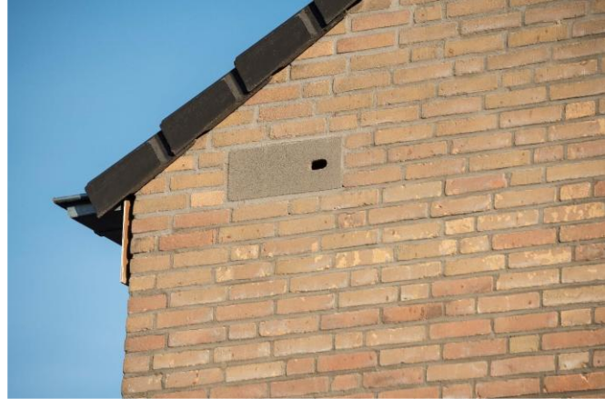
Figuur 3. Voorbeeld van gevelbetimmering met kasten (links) en praktijkvoorbeeld Arcadis prefab inbouwkast GZP2 Unitura (rechts).
