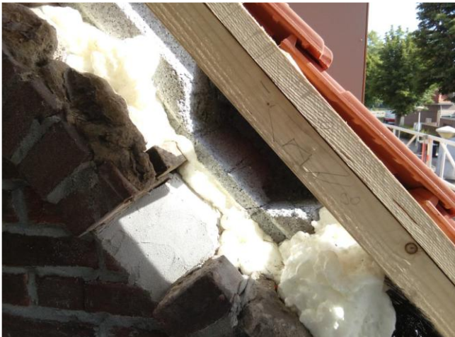
Figuur 4. Voorbeeld gierzwaluwverblijf via opening in rollaag naar ruimte onder kantpan. Dergelijke openingen kunnen ook toegang geven naar dakruimte voor vleermuizen, huismus en spreeuwen. Bron: Arcadis.
