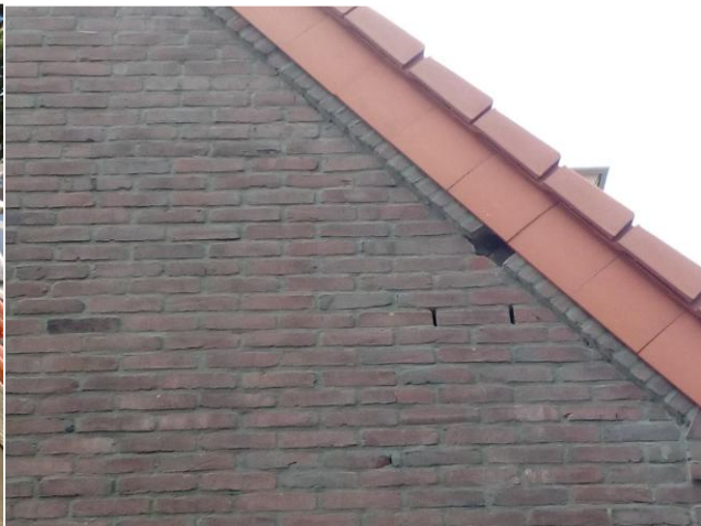
Figuur 4. Voorbeeld gierzwaluwverblijf via opening in rollaag naar ruimte onder kantpan. Dergelijke openingen kunnen ook toegang geven naar dakruimte voor vleermuizen, huismus en spreeuwen. Bron: Arcadis.
