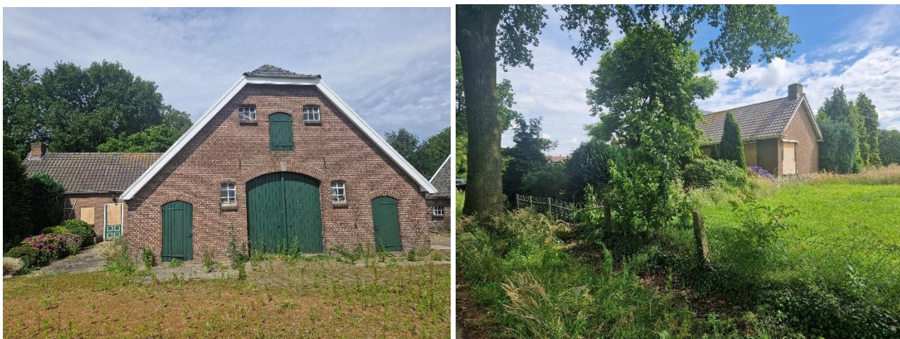
Figuur 24 Foto-impressie plangebied. Figuur links: Achterzijde van Nijkerkerweg 128. Figuur rechts: Voorzijde van Nijkerkerweg 128
