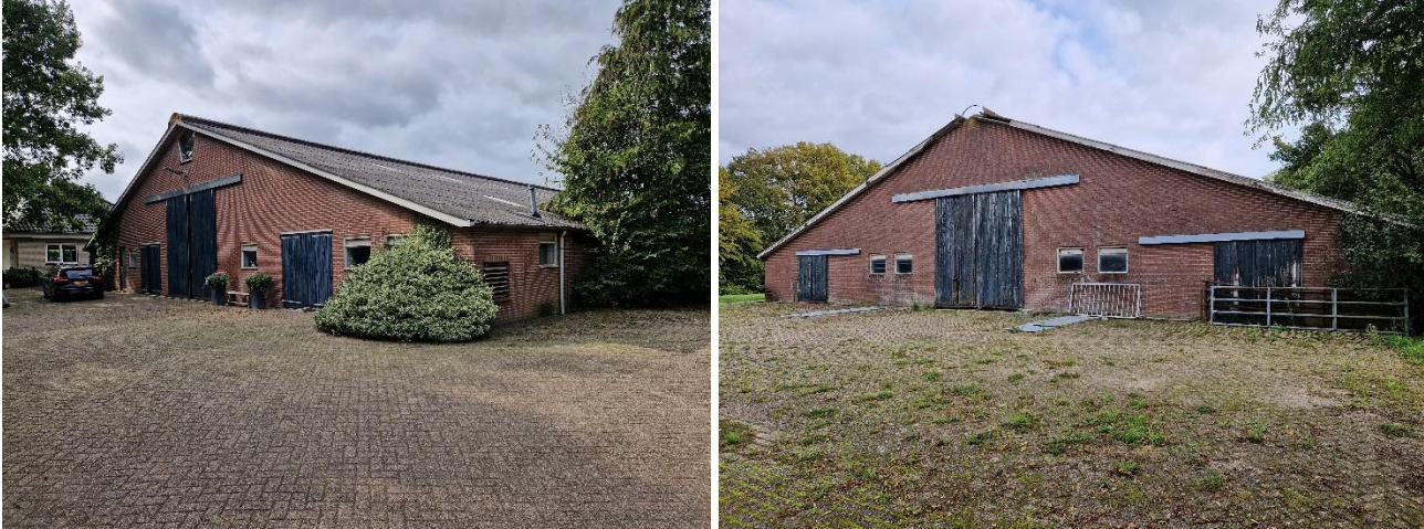
Figuur 28 Foto-impressie plangebied. Figuur links: Voorzijde voormalige koeienstal van Bloemendaallaan 77. Figuur rechts: Achterzijde voormalige koeienstal van Bloemendaallaan 77
