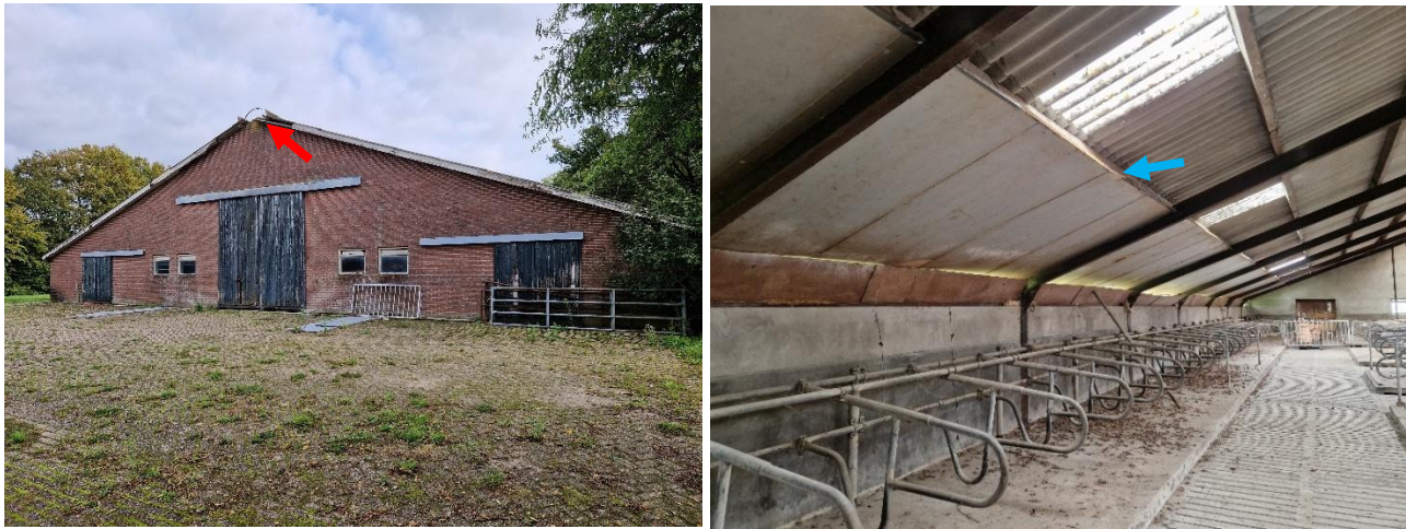
Figuur 42 Impressie van de voormalige koeienstal van Bloemendaallaan 77; toegankelijk via opening bij dakrand (zie rode pijl) en potentiële nestplaats van steenuil bij blauwe pijl
