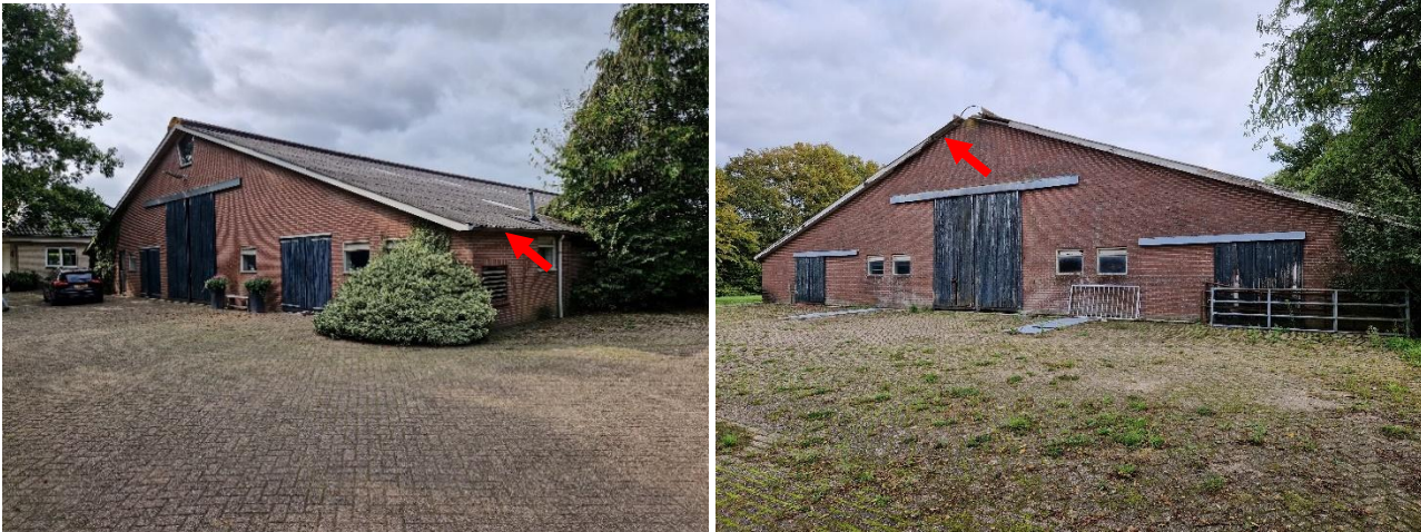
Figuur 35 Impressie van de voormalige koeienstal van Bloemendaallaan 77; toegang tot potentiële nest- en rustplaats van huismus aanwezig bij rode pijl
