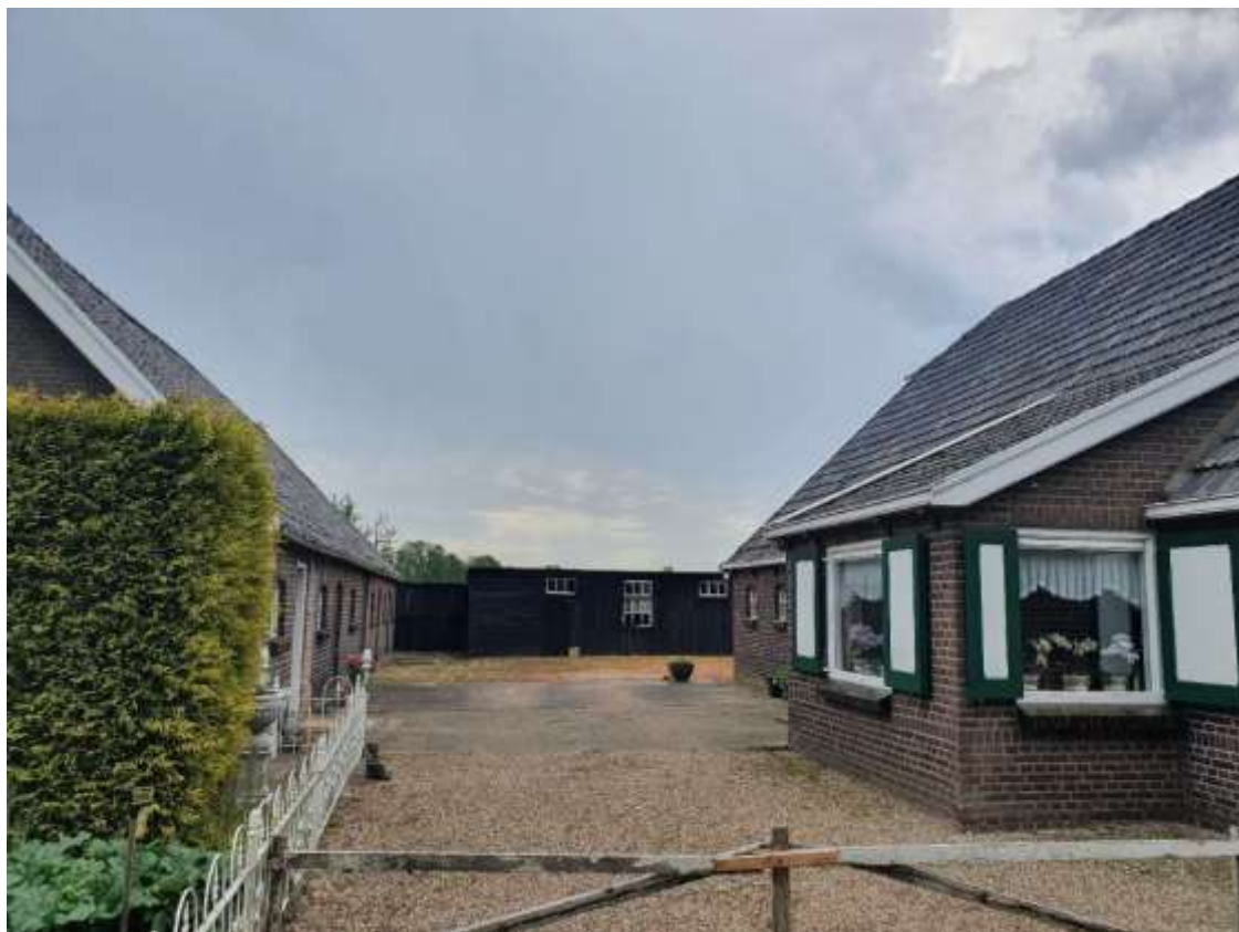
Deel 2 schuren aan de Nijkerkerweg 128 te Barneveld
