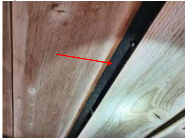
Projectfoto schuur 1 bitumen/dakleer
