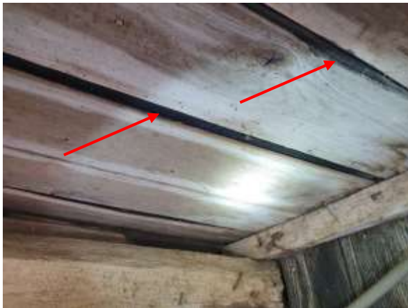
Projectfoto schuur 1 bitumen /dakleer
