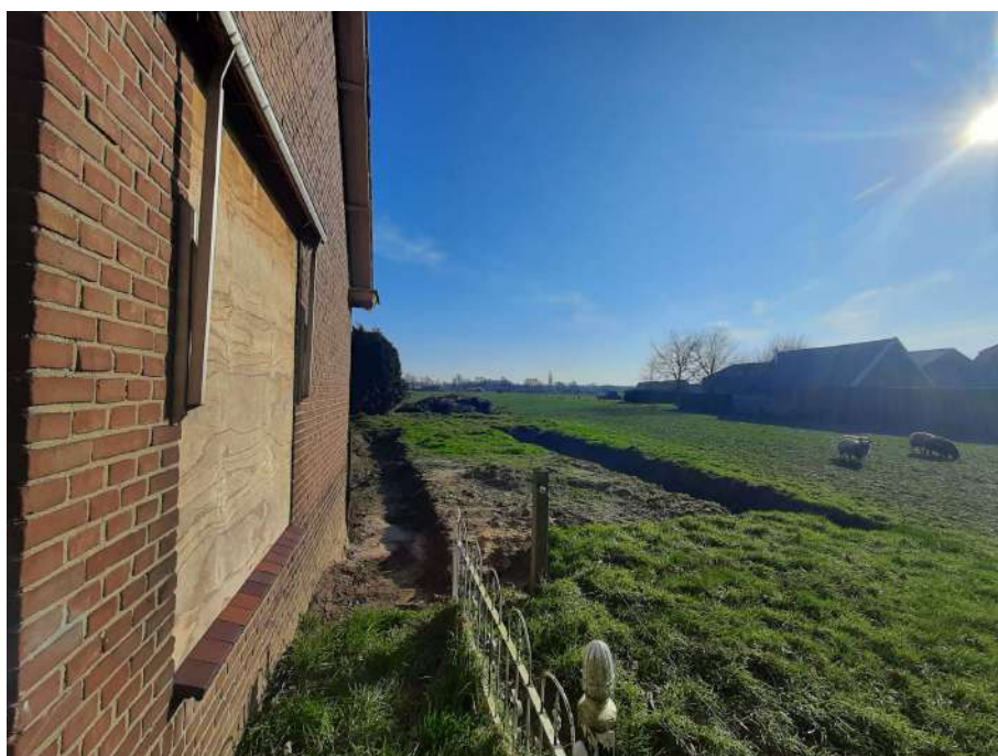
Zuidelijke schuur (gesloopt, deels gesaneerd)
