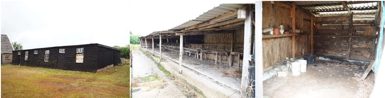
Figuur 2. De oostelijke schuur gezien vanuit de woning (links), de schuur vanuit het achterliggend weiland (midden) en de schuur van binnen (rechts).
