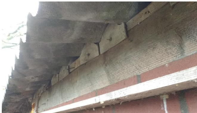
Foto 11: Asbestverdacht materiaal 41-45
