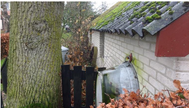
Foto 10: Afwatering schuur 1 noord
