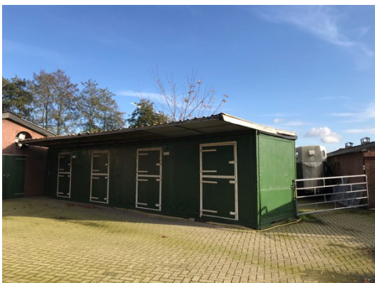
Gebouw L. Voormalige paardenstallen
