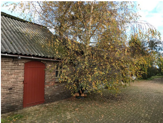
Gebouw J. Bijgebouw schuur/opslagruimte
