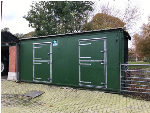
Gebouw E. opslagplaats
