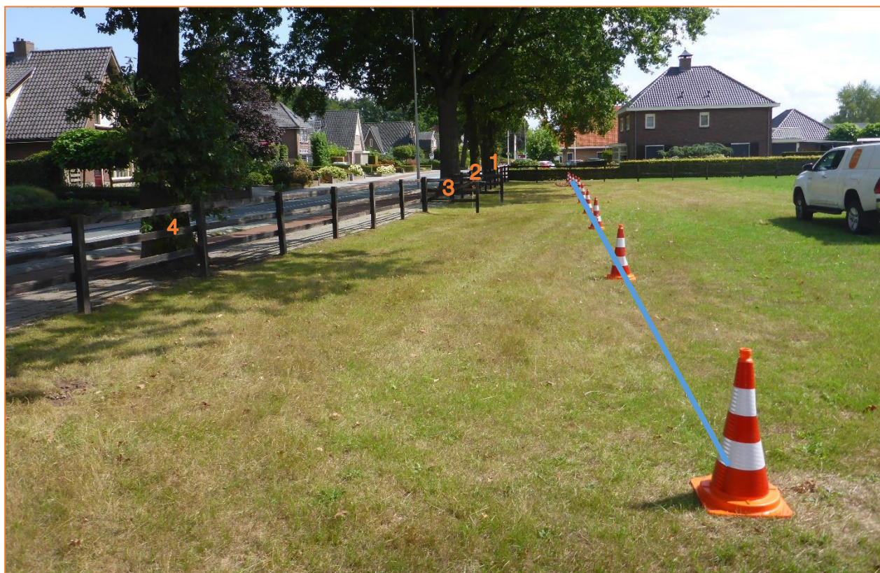
Foto 13: Voorbeeld van de lijn (blauw) waarbij de ontsluitingsweg op 5,5 meter afstand vanuit de boomstam aangehouden wordt. De boomnummers van de betreffende bomen zijn weergegeven.
