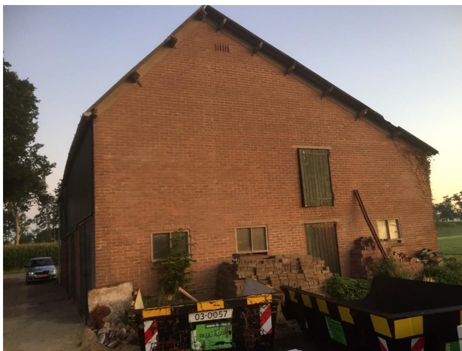
Figuur 4. De te slopen schuur
