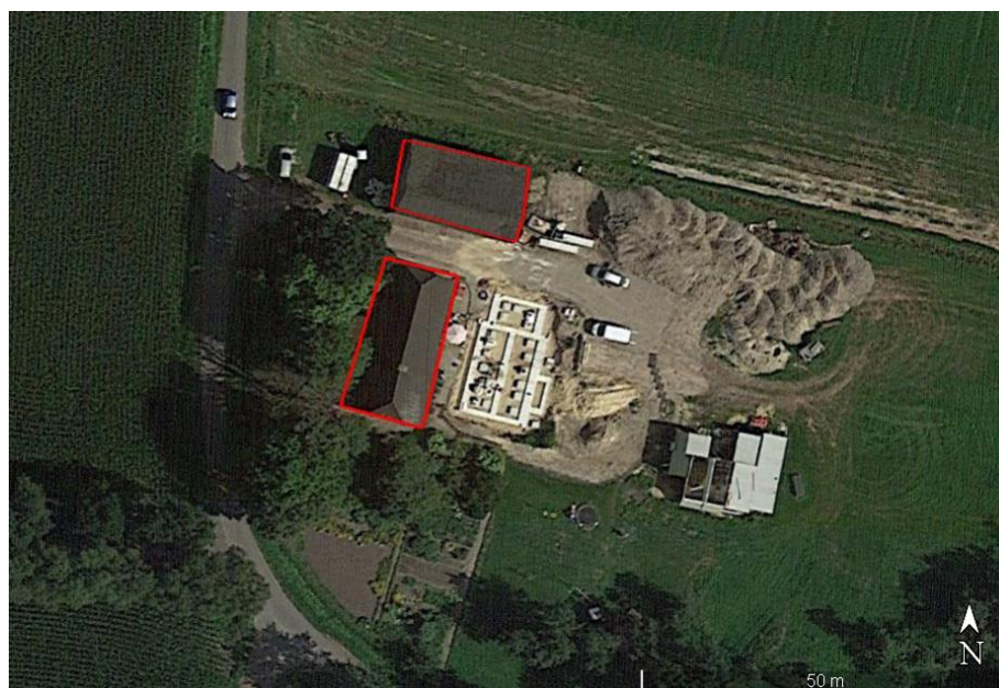
Figuur 2. Rood omlijnd de te slopen woonboerderij (onder) en schuur (boven)
