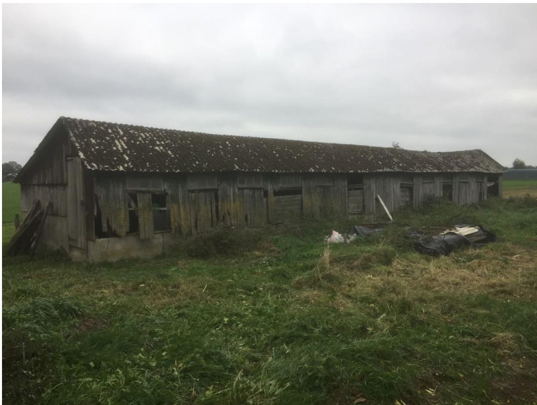
Figuur 2. Te slopen kippenhuur.
