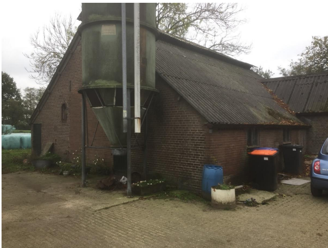
Figuur 3. Te slopen varkensstal met rechts het aangebouwde bakhuis.
