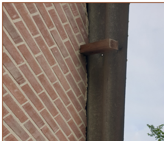
Afb. 2.7: De oostelijke kopgevel van de schuur. De bovenzijde van de gevel kiert ten opzichte van het dak. Hierdoor kunnen vleermuizen de luchtsponw bereiken en gebruiken als vaste rust- en verblijfplaats.
