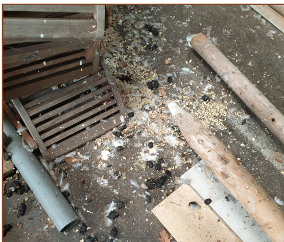
Afb. 2.6: In de schuur zijn veel sporen aangetroffen van de kerkuil. Het wordt verwacht dat de soort de schuur gebruikt als vaste rust- en verblijfplaats. De braakballen op locatie waren nog vers. De kerkuil broedt vermoedelijk in de loshangende isolatieplaten.
