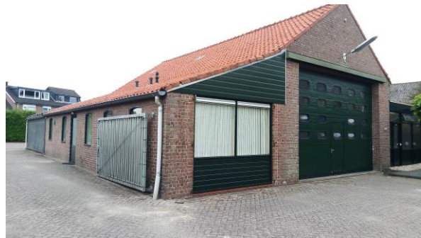
Foto 2: Voorzijde (zuidzijde garage) en oostzijde.
