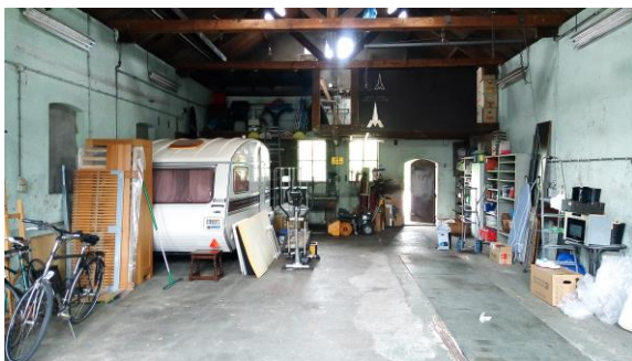
Foto 3: Inpandige situatie voormalige werkplaats/garage: betonvloer met privé opslag.
