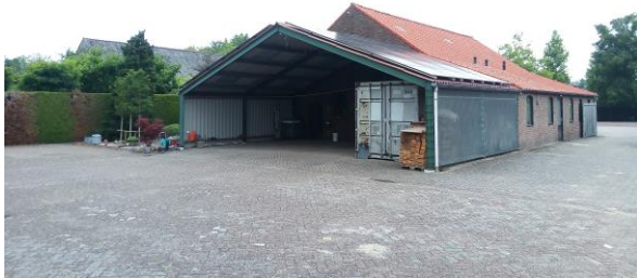
Foto 1: Achterzijde locatie met zicht op noordzijde garage met achterliggende overkapping.
