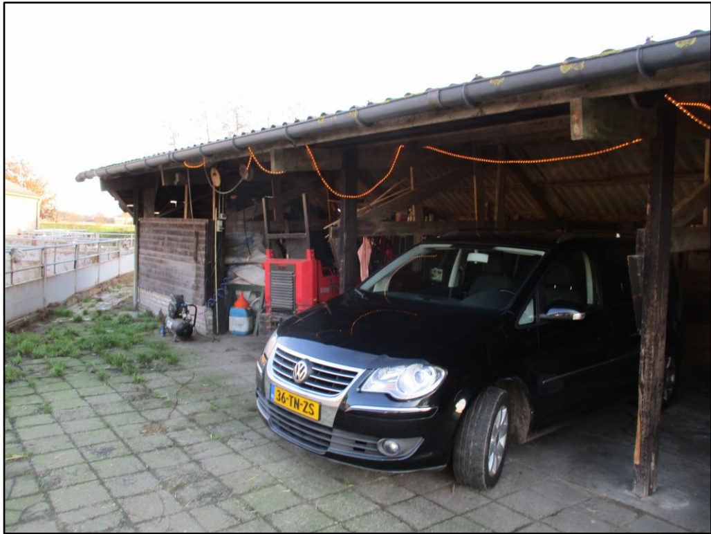
Figuur 3 De carport.
