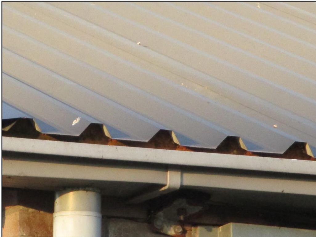
Figuur 5 Aanwezigheid van isolatiemateriaal onder het dak van stal G.
