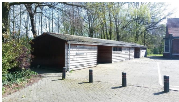
Foto 2: Fietsenhok aan de oostzijde van de onderzoekslocatie.
