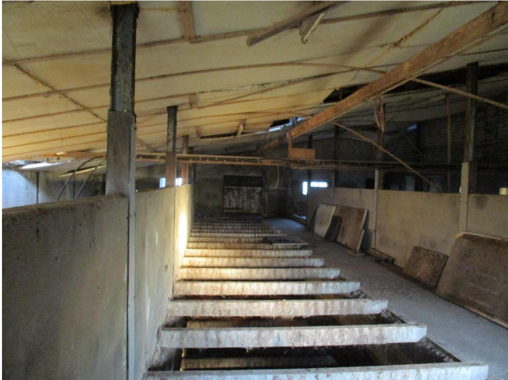
Figuur 2 De binnenkant van de veestal.
