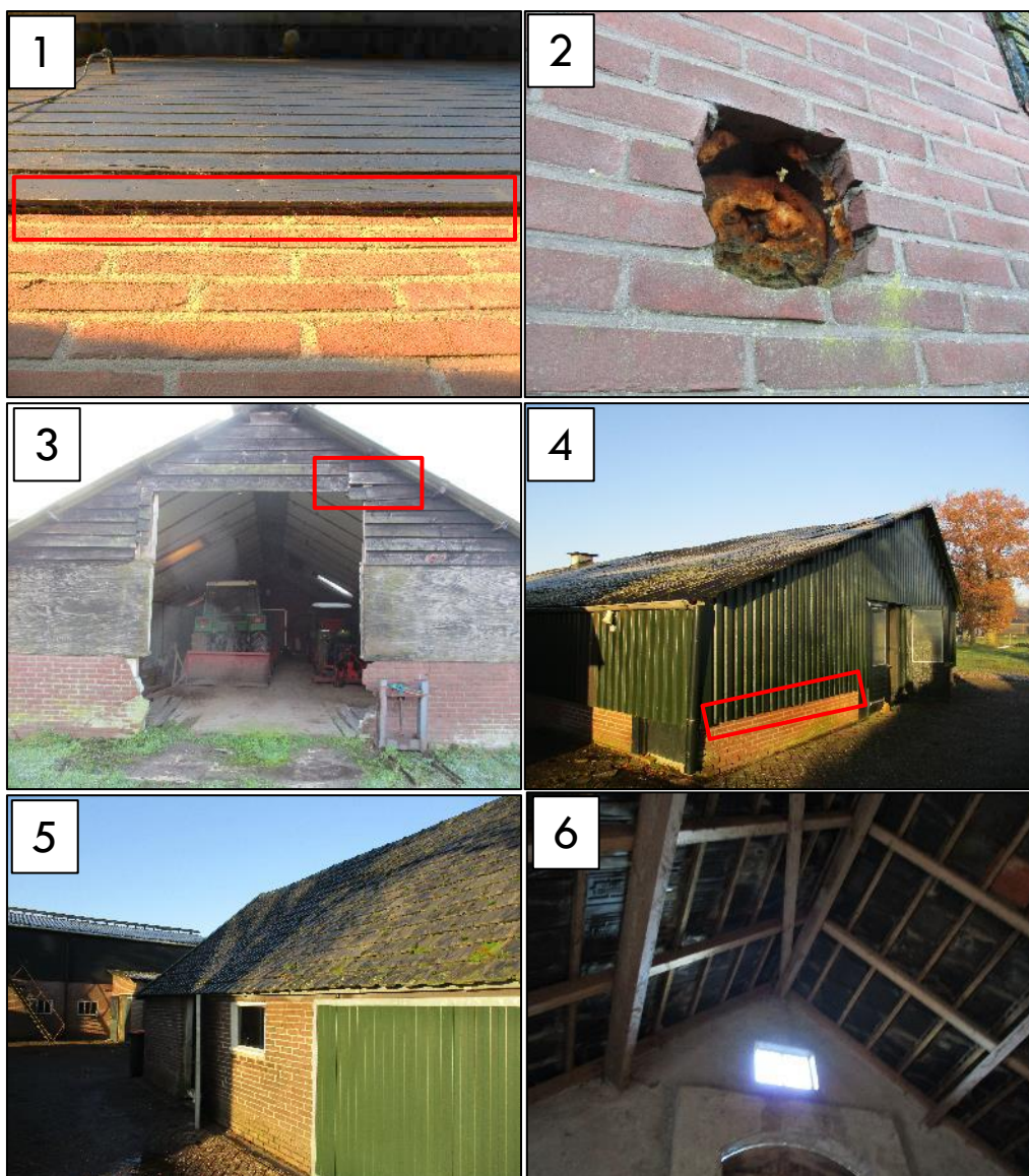
Figuur 5 De aangetroffen openingen leiden niet tot kruipruimtes waar vleermuizen gebruik van kunnen maken.
