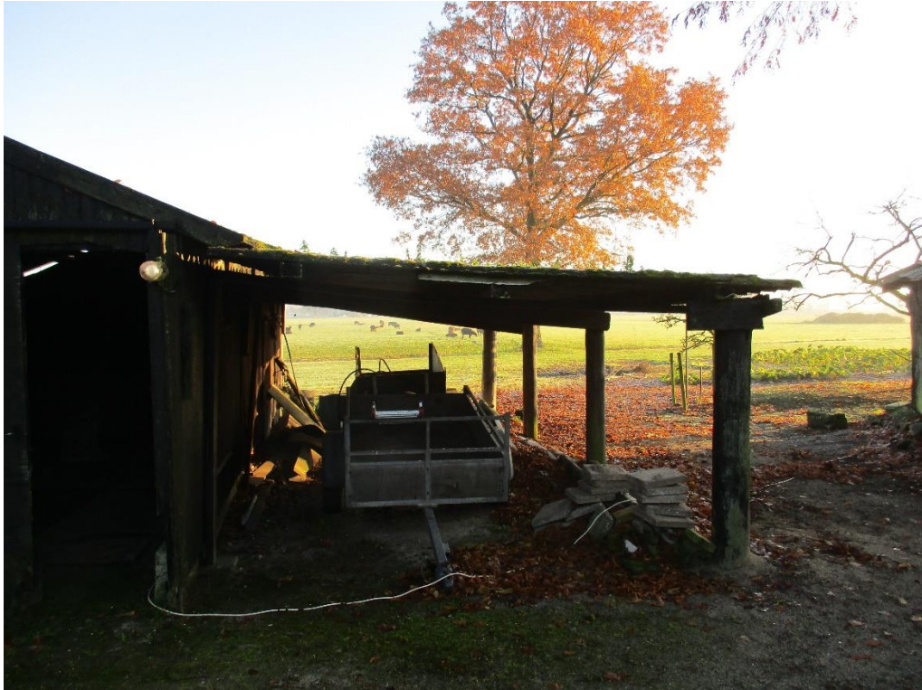
Figuur 4 De overkapping naast schuur D.
