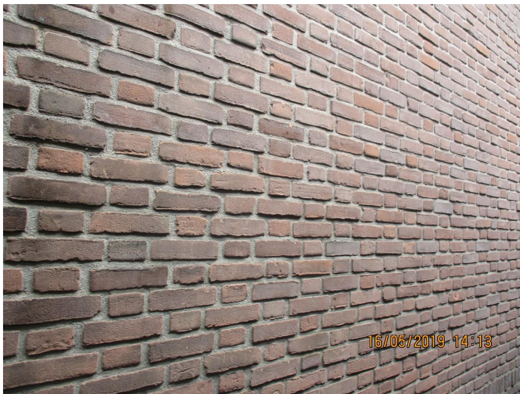
Figuur 3 De muren bestaan uit steense muren zonder spouw.
