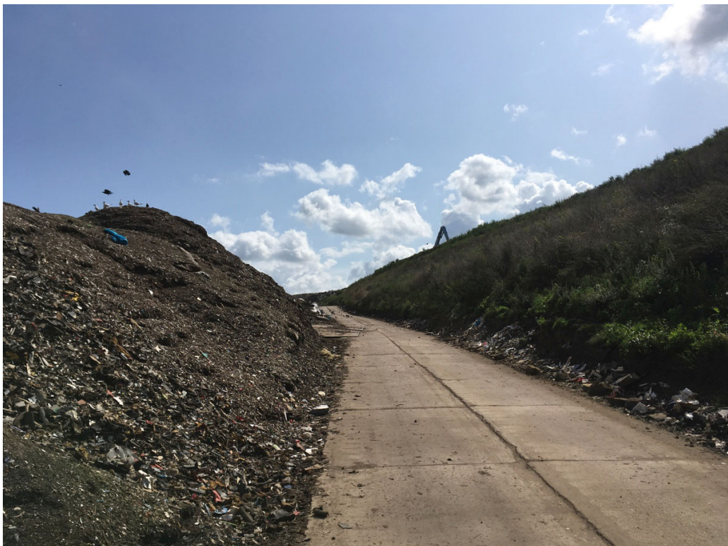
Afbeelding 2 Zicht op de planlocatie vanaf de ontsluitingsweg. Deze zal (na het verwijderen van de stelconplaten) ook worden opgehoogd met afval.
