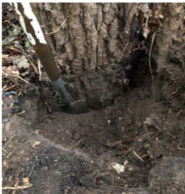
Ophoging bij boom 19 met minimaal 50 cm waardoor de stam mogelijk aangetast kan zijn.
