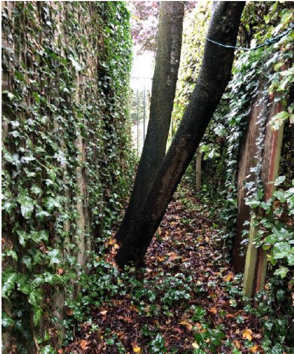
Boom 26 ontleent teveel steun aan de muur van de te slopen berging om behouden te kunnen blijven.
