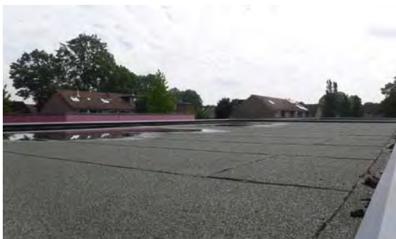
Dakbedekking (bovenste laag) is niet asbestverdacht.
