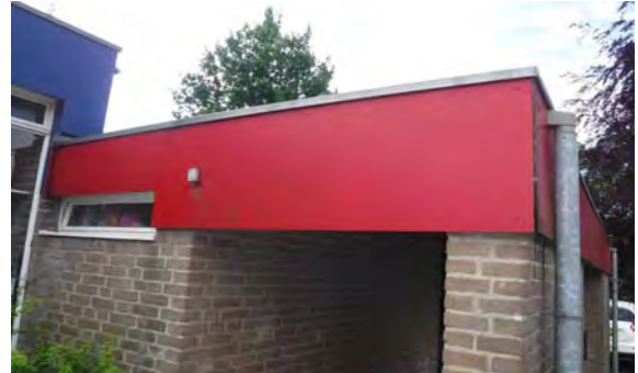
Boeiboorden zijn niet asbestverdacht (Trespa)
