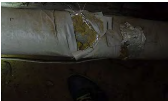
Aangetroffen leidingisolatie is niet asbestverdacht.
