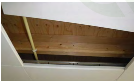
Houtenbalklaag zichtbaar boven het systeemplafond.
