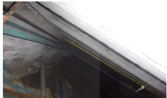
In de kruipruimte zijn geen asbestverdachte materialen aangetroffen
