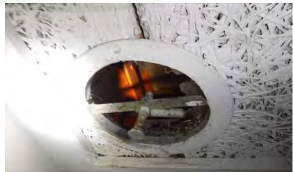
Geen asbest verdachte materialen aangetroffen boven het verlaagde plafond
