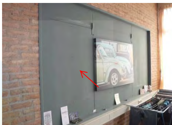
Asbesthoudende plaat
