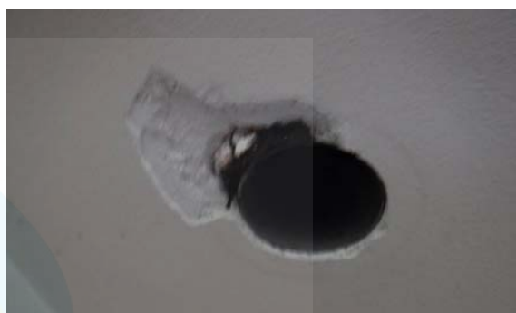
Gipsplafond in het toilet
