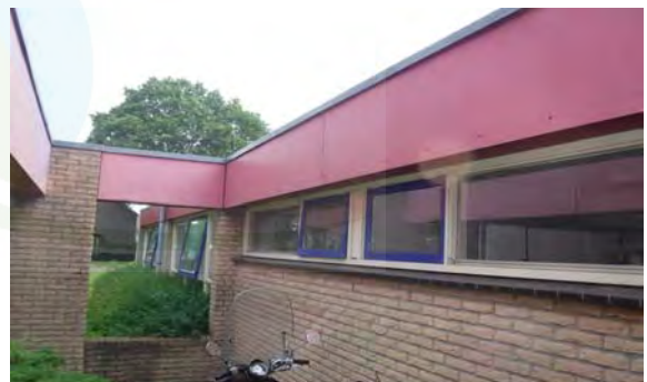
Boeiboorden zijn niet asbestverdacht (Trespa)
