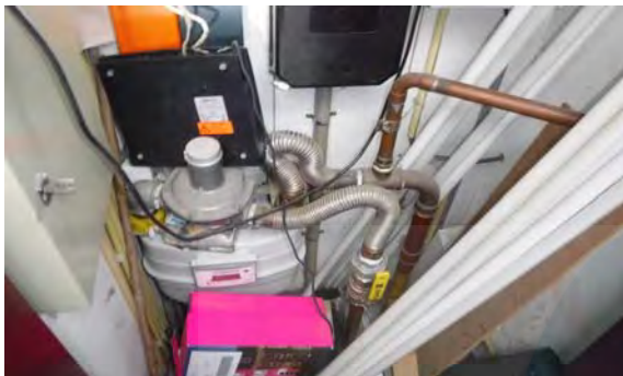
Meterkast niet asbestverdacht
