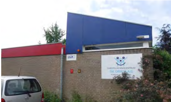
Gevelpanelen zijn niet asbestverdacht
