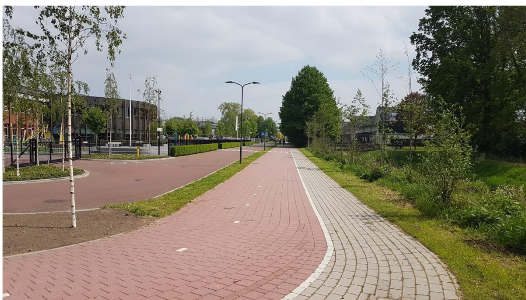
Zuidelijk deel terrein mobiel GOS en split-Tee bij de Schoutenstraat (Barneveld), gefotografeerd in oostelijke richting (Natuurbalans, 1-5-2019).
