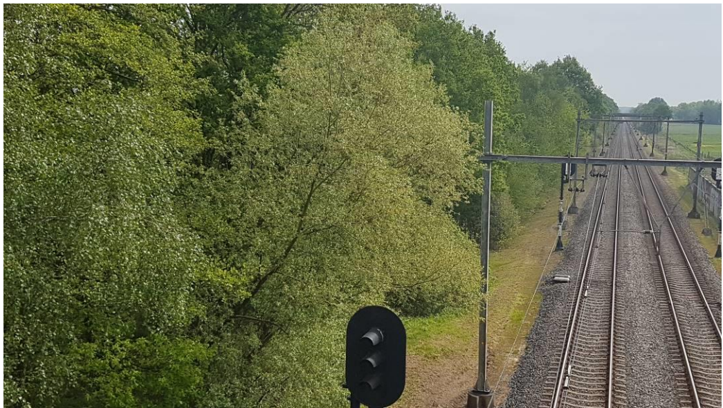
Zicht op een deel van het terrein van de te verwijderen leiding langs de A1, gefotografeerd vanaf de Stoutenburgerlaan (Terschuur) in oostelijke richting (Natuurbalans, 1-5-2019).
