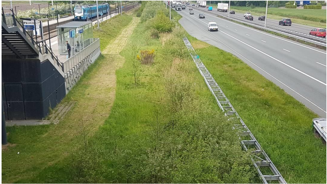
Zicht op een deel van het terrein van de te verwijderen leiding langs de A1, gefotografeerd vanaf de Stoutenburgerlaan (Terschuur) in westelijke richting (Natuurbalans, 1-5-2019). Ter hoogte van het einde van het perron begint S-6397 (b).
