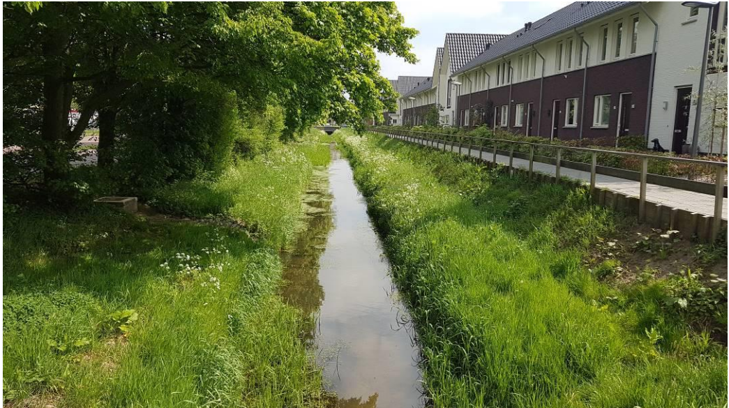
Zuidelijk deel terrein mobiel GOS en split-Tee langs de Kleine Barneveldsche beek, zuidzijde Schoutenstraat (Barneveld), gefotografeerd in oostelijke richting (Natuurbalans, 1-5-2019).
