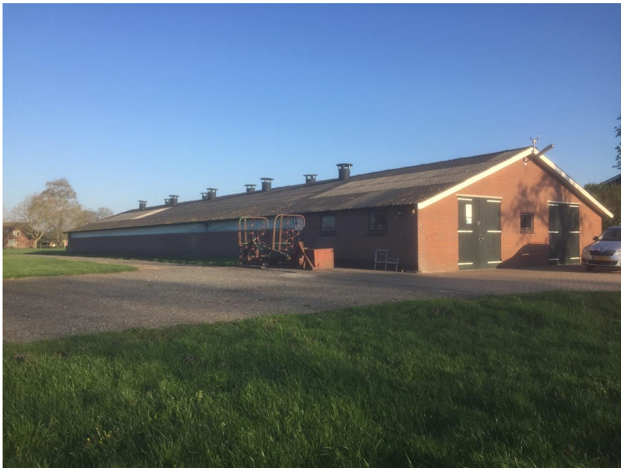
Figuur 2. Te slopen stal.
