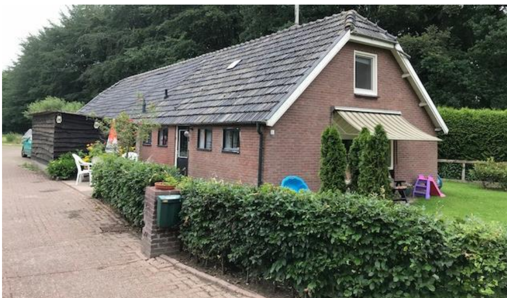
Figuur 2 Een van de woningen die is gelegen op het perceel zal worden gesloopt om plaats te maken voor een nieuwe woning
