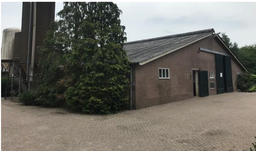
Figuur 1 De koeienschuur die is gelegen op een van de percelen zal worden gesloopt. Deze schuur is niet geïsoleerd.
