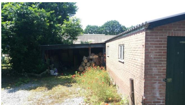
Foto 1: Eén van de schuren op het terrein.
