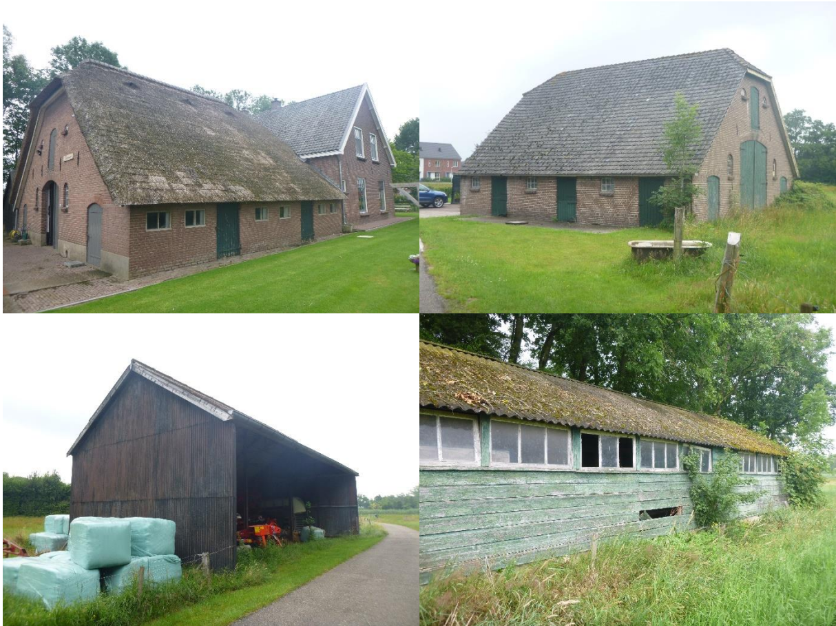
Figuur 2-2. Huidige situatie gebouwen. Van links naar rechts en van boven naar beneden: boerderij (blijft behouden), stenen schuur zonder spouw met dakpannen; open opstal met houten wanden en golfplaten dak en vervallen houten schuur.
