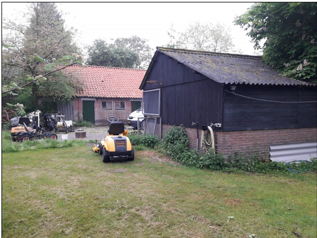
Deellocatie 1 – Achterveldseweg 11: asbestverdachte schuur, klinkerverharding en grasveld.
