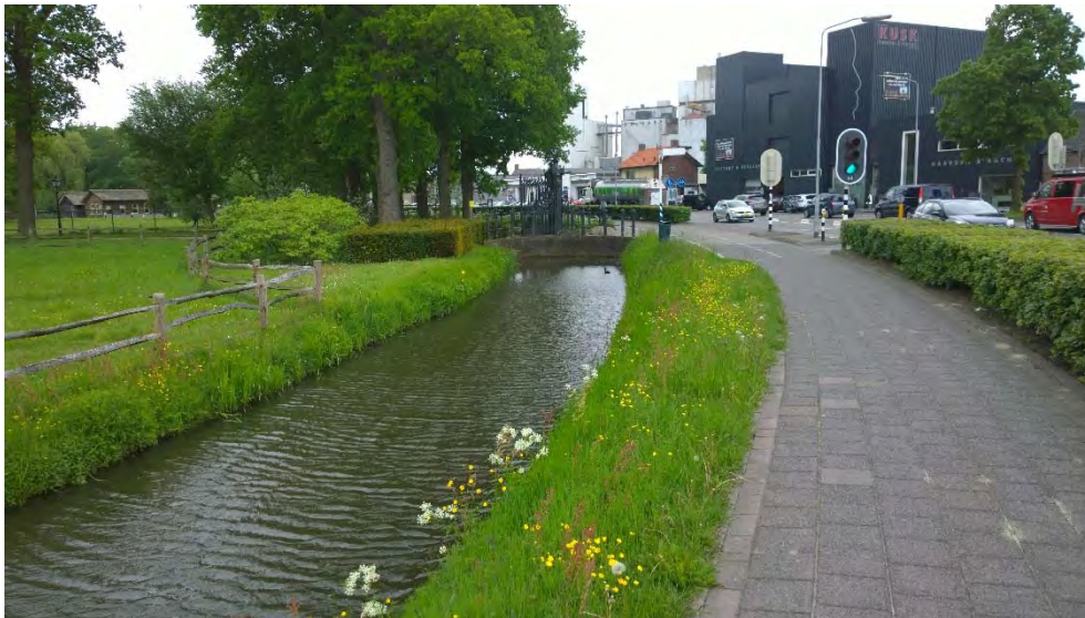
Foto 4. Situatieoverzicht deelgebied 4 oostzijde
