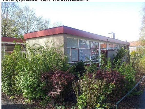
Foto 6. Kantoorpand vanuit het noordoosten.
