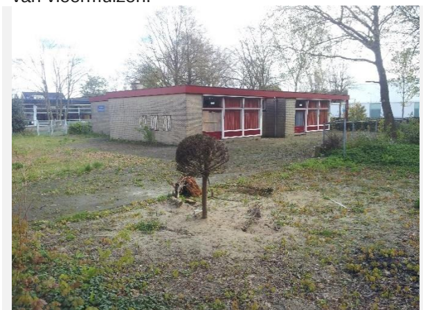
Foto 5. Kantoorpand vanuit het zuidwesten.
