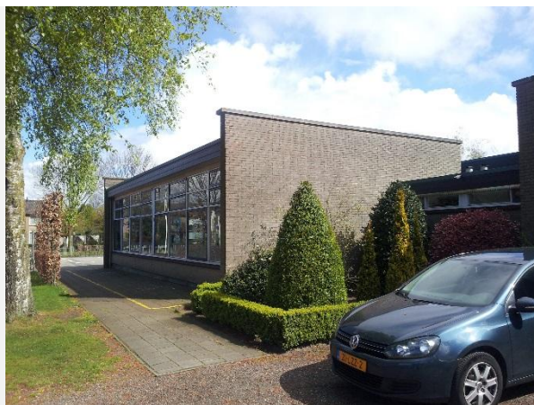
Foto 2. Schoolgebouw vanuit zuidwesten. Aangrenzende struiken vormen nestplaatsen van broedvogels, zoals merel.
