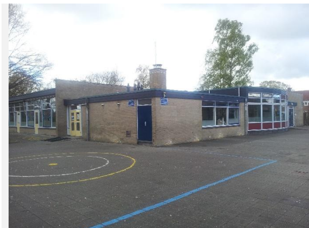
Foto 1. Schoolgebouw vanuit het noordwesten.
