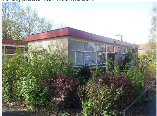
Foto 6. Kantoorpand vanuit het noordoosten.
