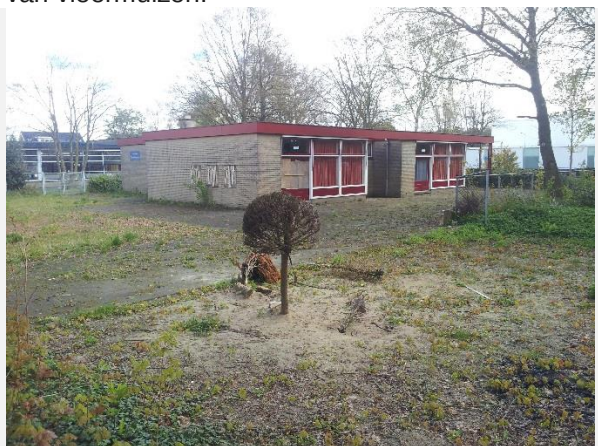
Foto 5. Kantoorpand vanuit het zuidwesten.
