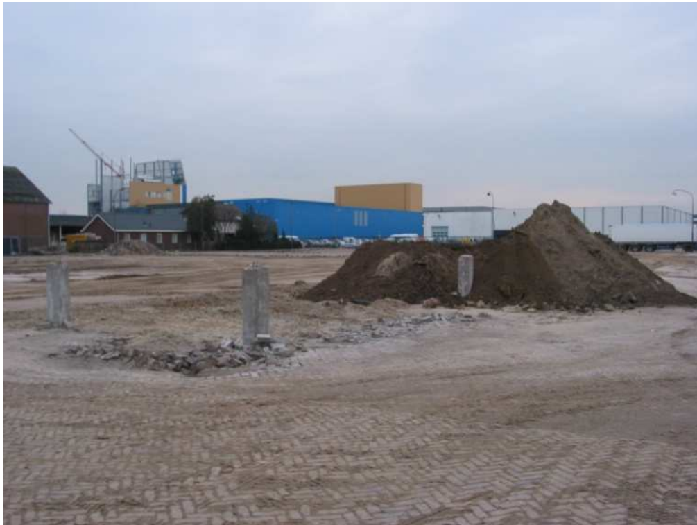
Foto 1 , gronddepot 1, grond wat is vrijgekomen bij blootleggen van de fundamente tijdens de sloop van de gebouwen.
