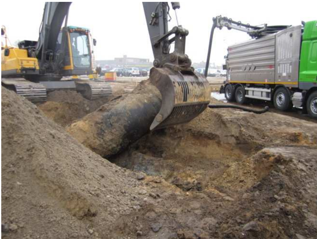
Foto 2 , Verwijderen tank 6.000 l
