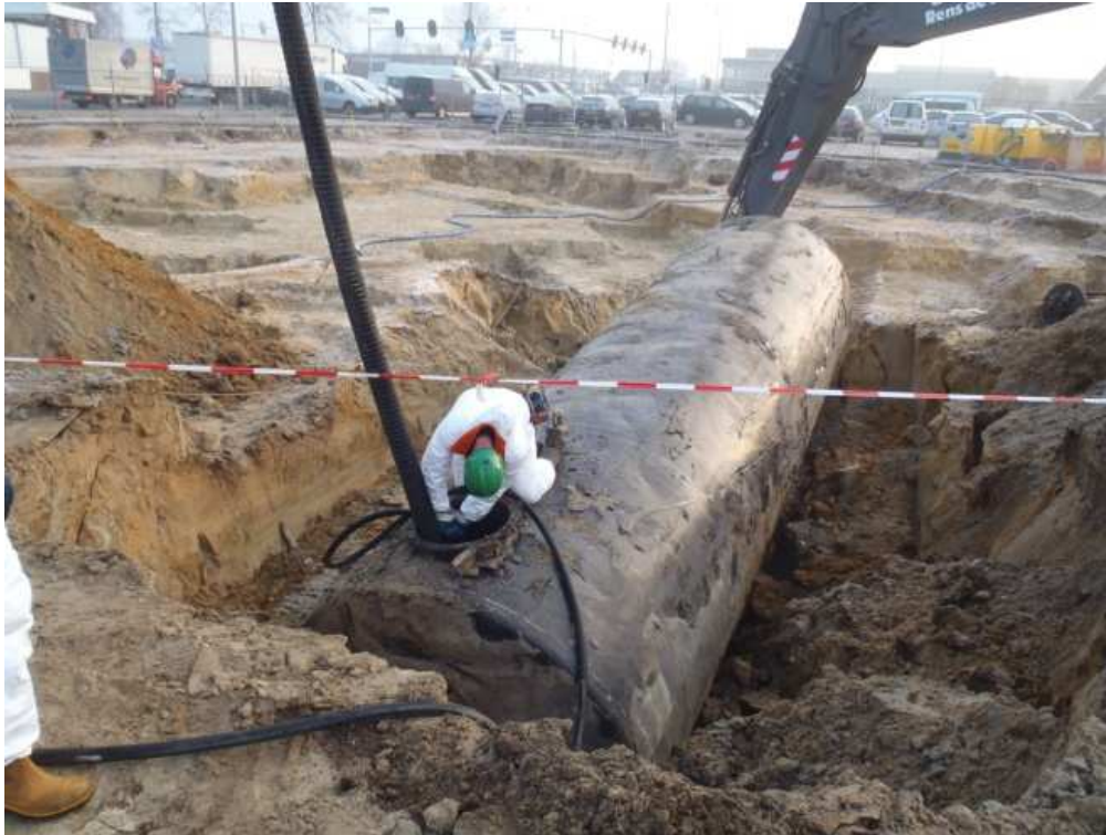
Foto 3, Leegzuigen en reinigen tank 30.000 l
