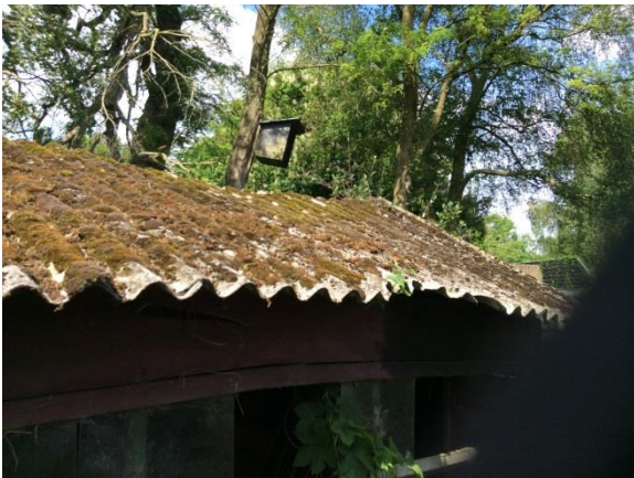
Figuur 11: Overzichtsfoto bebouwing
