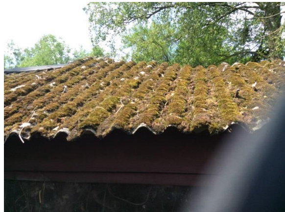
Figuur 12: Overzichtsfoto bebouwing
